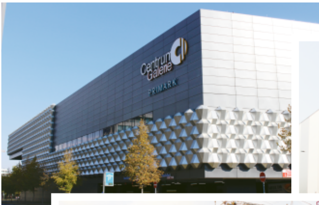
Centrum Galerie, Dresden
