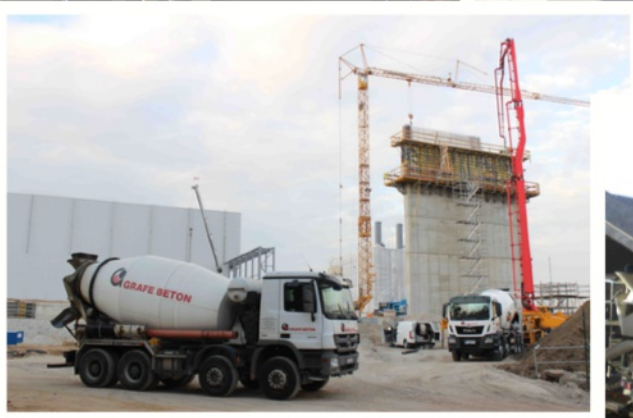
Elbe Flugzeugwerke, Dresden
